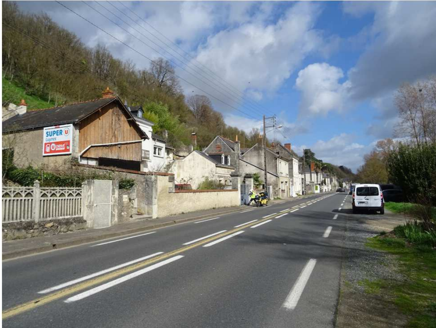
ST ETIENNE DE CHIGNY quai de la Loire
