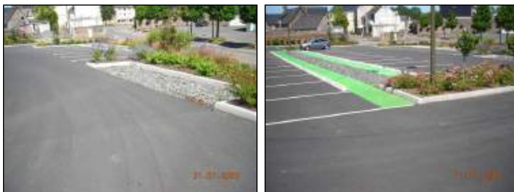
Photo 4 : Exemple de tranchées drainantes
