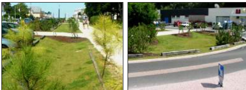
Photo 3 : Exemple de réalisation de noues paysagères
