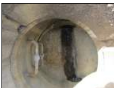
Photo 4 : Ecoulement temps sec regard 0084 allée du Rabasou (bassin versant 24)
