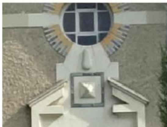
Décor singulier : linteau à fronton triangulaire interrompu et décor en modénature servant d'appuis à une baie de type oculus à encadrement en brique bicolor (brun-jaune et gris)
