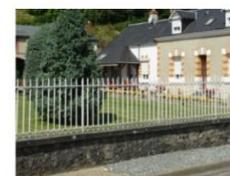
Muret avec parement moellons et chapeau en pierre de taille surmonté d'une grille métallique
