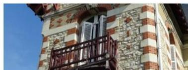
Mélange brique et enduit lissé dans les encadrements
