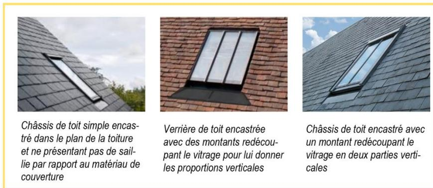
Châssis de toit simple encastré dans le plan de la toiture et ne présentant pas de saillie par rapport au matériau de couverture
