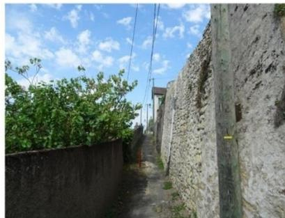
Système de double mur de soutènement d'un côté et de l'autre d'une venelle à mi-coteau
