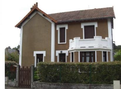
Maison en maçonnerie récente (béton, ciment, parpaing), dont la façade est travaillée des peintures et un enduit à la tyrolienne
