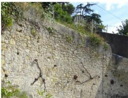
Mur de soutènement en moellons grossièrement équarris
