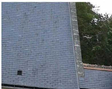
Exemples de couvertures en ardoise. À gauche, couverture ancienne avec pignon à rondelis. À droite, couverture plus récente dans la forme avec le traitement des arêtes et du faitage en zinc (sur maison de maître).
