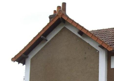
Exemples de couvertures en tuiles mécaniques avec l'emploi de tuiles de rabat et d'éléments décoratifs
