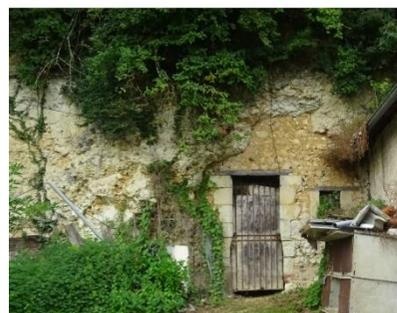
Entrée d'habitat troglodytique avec porte et fenêtre, linteau bois, jambages en pierre de taille (pierre extraite du coteau) et paroi partiellement maçonnée
