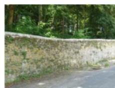
Mur traditionnel en moellons de calcaire avec chapeau arrondi : il est possible de remonter un mur neuf avec un parement en moellons
