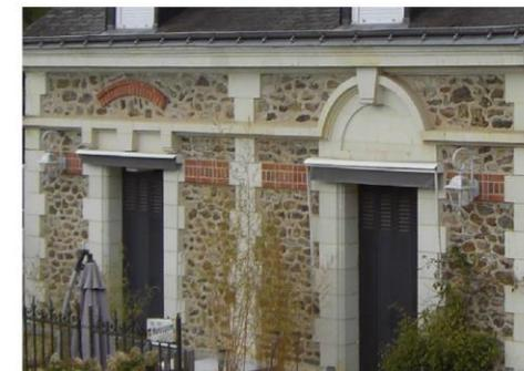
Façade en moellons appareillés à la façon de la "meulière", les encadrements et chaînage sont en pierre de taille, bandeaux et arc de décharge en brique : on devine donc au moins trois matériaux en façade
