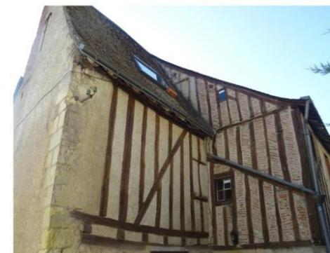
Pan de bois traditionnel avec remplage mixte brique en arête de poisson, moellons enduits, etc.
