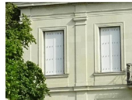
Maçonnerie en pierre de taille, modénatures qui soulignent la façade : encadrement en saillie, bandeau, pilastre encastré, corniche à modillons
