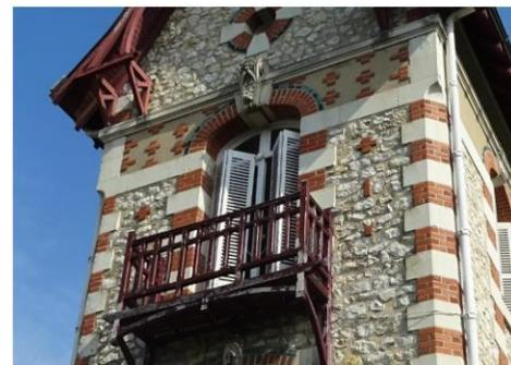
Façade en moellons grossièrement équarris, les encadrements et chaînage sont en pierre de taille et brique. Des briques incrustées dans la maçonnerie forment des décors
