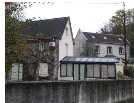
Extension sous forme de verrière (jardin d'hiver) avec soubassement maçonné. Partition verticale des vitrages
