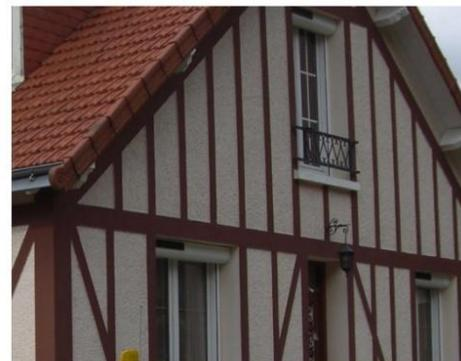
Faux pan de bois constitué de maçonneries en ciment et de béton peint
