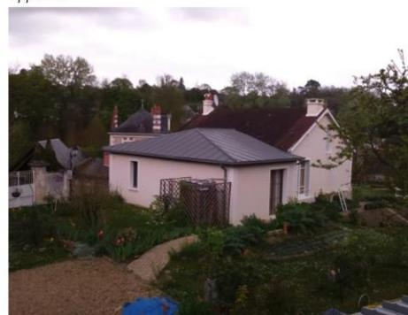
Extension d'une maison des années 1930 réalisée avec quatre pans (zinc) dans l'esprit d'un volume accolé
