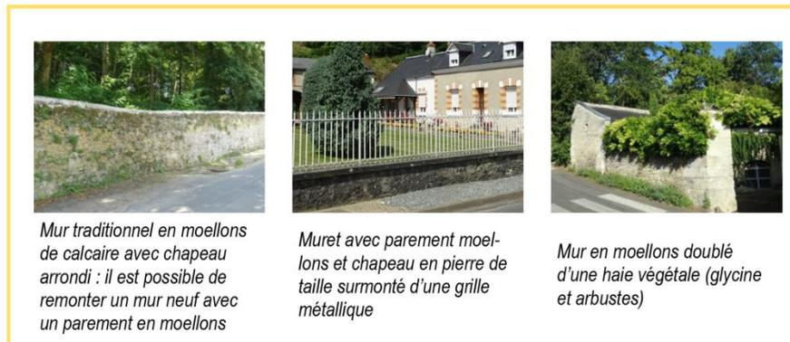
Mur traditionnel en moellons de calcaire avec chapeau arrondi : il est possible de remonter un mur neuf avec un parement en moellons
