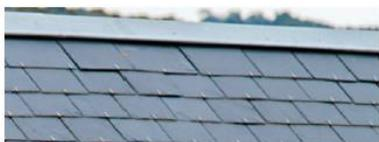
Exemple faitage en zinc sur une couverture en ardoise (constructions nouvelles uniquement)
