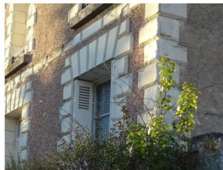
Maçonnerie en moellons enduit (reprise en ciment sur la façade principale), encadrements des baies et chaîne d'angle harpée en bossage.
