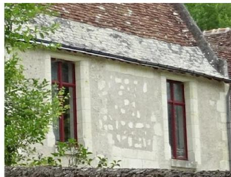
Maçonnerie en moellons enduit avec vestige d'une baie ancienne sur le trumeau. Encadrements en pierre de taille.
