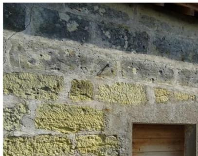
Maçonnerie en pierre de taille composée de Tuffeau jaune partiellement retaillé. Reprise du linteau en ciment malheureuse
