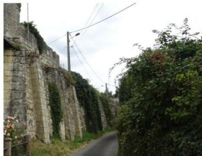
Mur de soutènement épaulé par des contreforts massifs en pierre de taille. Le mur est lui-même composé d'une maçonnerie appareillée
