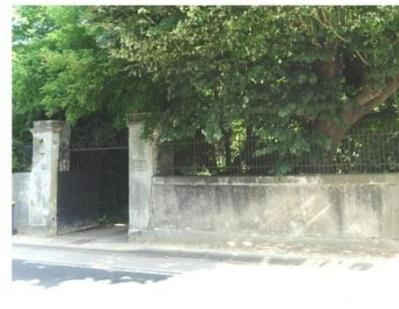
Mur bahut maçonné (moellons) et enduit, surmonté d'une grille de teinte sombre
