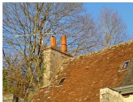
Cheminée en brique sur pignon, le solin qui assure la jonction entre la brique et la tuile est réalisé en mortier
