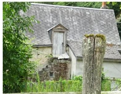
Escalier en brique permettant l'accès aux combles d'un bâtiment rural situé à Bel-Air
