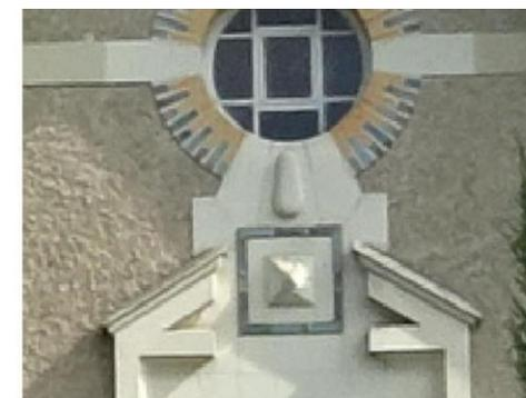
Décor singulier : linteau à fronton triangulaire interrompu et décor en modénature servant d'appuis à une baie de type oculus à encadrement en brique bicolore (brun-jaune et gris)
