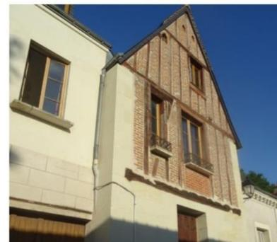
Pan de bois destiné à rester apparent avec un remplissage brique régulier et une composition dans l'assemblage du bois
