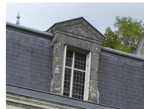
Lucarne classique en pierre de taille à fronton triangulaire, sur le brisis d'une toiture à mansarde
