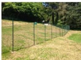
Exemple de grillage simple torsion métallique et de teinte foncée.
