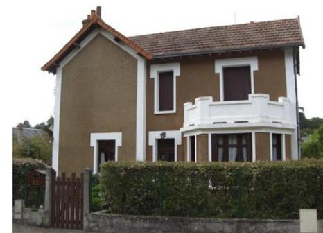
Maison en maçonnerie récente (béton, ciment, parpaing), dont la façade est travaillée avec des peintures et un enduit à la tyrolienne
