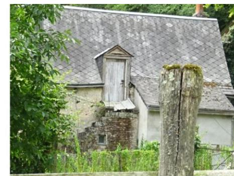
Escalier en brique permettant l'accès aux combles d'un bâtiment rural situé à Bel-Air
