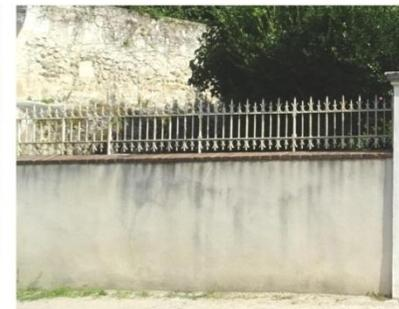
Mur bahut maçonné (moellons) et avec un enduit contemporain peu respirant, surmonté d'une grille ouvragée métallique sombre festonnée. Proportion de 2/3 de mur et 1/3 de grille.
