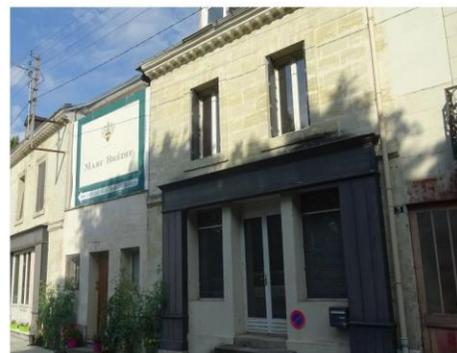
Maçonnerie en pierre de taille, chaîne d'angle droite en bossage
