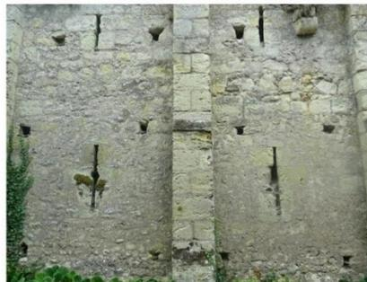
Mur de soutènement composé de moellons de calcaire, contrefort en pierre de taille, ouvertures de type "meurtrière" pour assurer la respiration du mur
