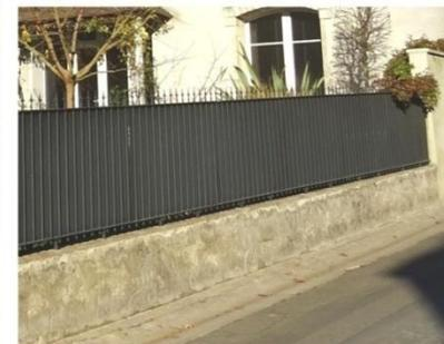
Mur bahut maçonné (moellons) et enduit surmonté d'une grille métallique sombre festonnée. Proportion de 1/3 de mur et 2/3 de grille.
