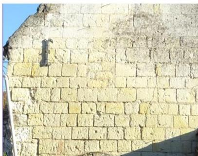
Maçonnerie en pierre de taille, constituée de Tuffeau jaune. L'appareil, composé
