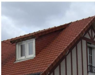
Exemples de couvertures en tuiles mécaniques avec l'emploi de tuiles de rabat et d'éléments décoratifs. La couleur est uniforme et le modèle de la tuile souvent le même
