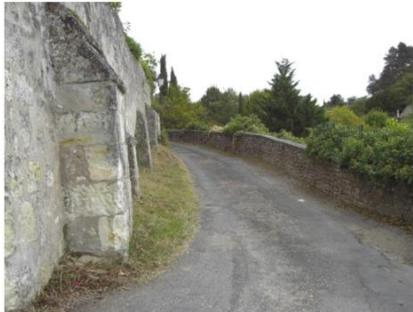
Principe de voie à mi-coteau avec deux murs de soutènement qui l'encadrent
