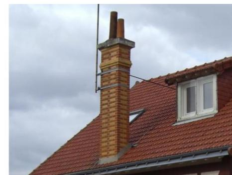
Cheminée en brique, deux couleurs, dessin ornemental dans l'appareillage des briques. Système de tirant assez discret
