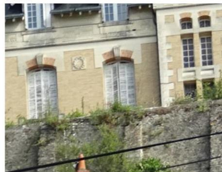
Façade du château de Sens, maçonnerie en béton et brique brun-jaune de parement. Pierre de taille en placage
