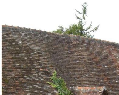
Exemples de couvertures traditionnelles en petites tuiles plates de Touraine. La diversité des couleurs de la tuile (dans un dégradé de brun vieilli) et parfois les ondulations induites par le vieillissement des chevrons de la charpente font le charme de ces couvertures
