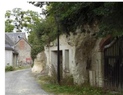
Entrée de cave avec linteau en brique et ancienne entrée d'habitat troglodytique reprise avec maçonneries en ciment, les maçonneries anciennes disparaissent
