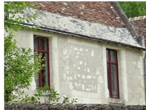
Maçonnerie en moellons enduit avec vestige d'une baie ancienne sur le trumeau. Encadrements en pierre de taille.
