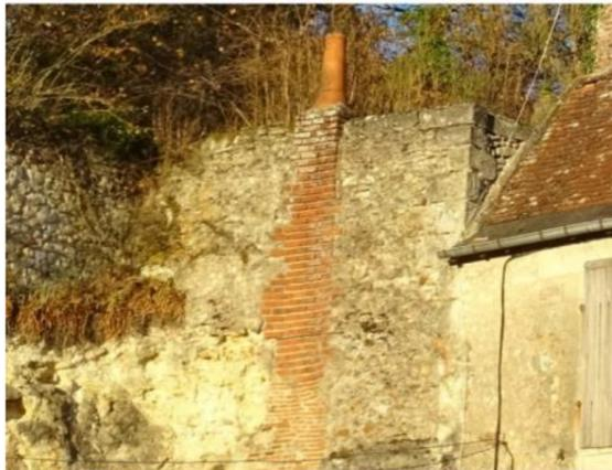
Cheminée en brique dans un mur de soutènement à flanc de coteau, cheminée troglodytique
