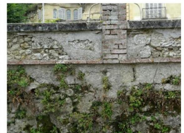
Maçonnerie ancienne, mur de clôture surélevé au-dessus d'un bandeau en brique. Piliers de maintien en brique
