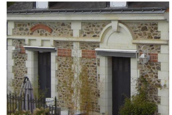
Façade en moellons appareillés à la façon de la "meulière", les encadrements et chaînage sont en pierre de taille, bandeaux et arc de décharge en brique : on devine donc au moins trois matériaux en façade
