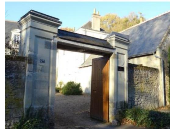
Portail de grande propriété couvert d'un auvent. Porte en bois laissé apparent. Peindre le bois permet de le protégé du vieillissement
