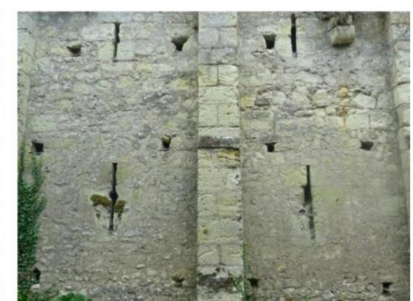
Mur de soutènement composé de moellons de calcaire, contrefort en pierre de taille, ouvertures de type "meurtrière" pour assurer la respiration du mur
