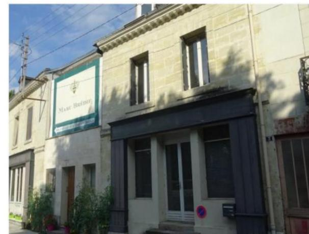
Maçonnerie en pierre de taille, chaîne d'angle droite en bossage
