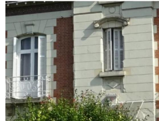
Maçonneries mixtes en fonction des volumes : pierre de taille pour la partie en saillie, les encadrements (harpés) et la corniche ; brique pour les maçonneries en retrait
