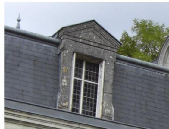
Lucarne classique en pierre de taille à fronton triangulaire, sur le brisis d'une toiture à mansarde
