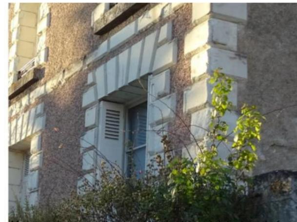
Maçonnerie en moellons enduit (reprise en ciment sur la façade principale), encadrements des baies et chaîne d'angle harpée en bossage.
