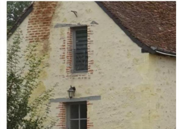
Maçonnerie ancienne en moellons de calcaire, les ouvertures ont été remaniées, les jambages refaits en petites briquettes, tandis que les linteaux sont en bois
