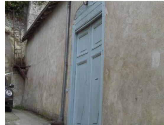
Porte en bois avec encadrements en bois, teinte gris-bleu moyen. Assemblages de panneaux de bois avec cadres moulurés
