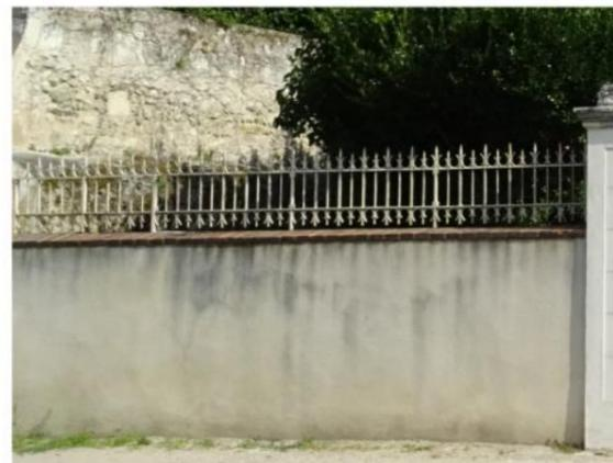
Mur bahut maçonné (moellons) et avec un enduit contemporain peu respirant, surmonté d'une grille ouvragée métallique sombre festonnée. Proportion de 2/3 de mur et 1/3 de grille.
