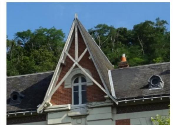
Lucarne pignon avec toiture en débord et éléments de charpente apparents
