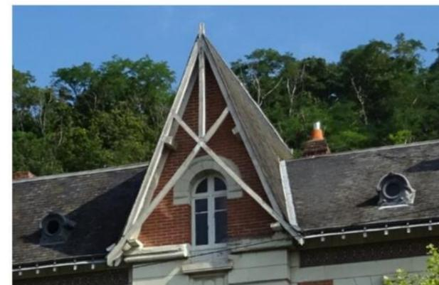
Lucarne pignon avec toiture en débord et éléments de charpente apparents
