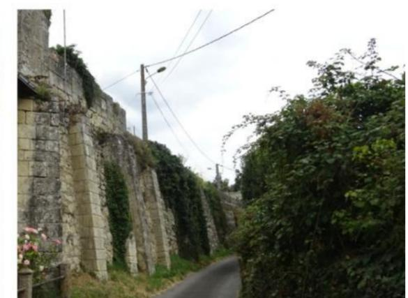
Mur de soutènement épaulé par des contreforts massifs en pierre de taille. Le mur est lui-même composé d'une maçonnerie appareillée
