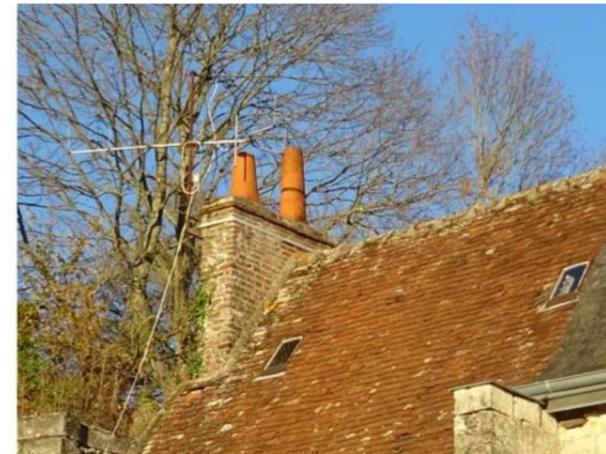
Cheminée en brique sur pignon, le solin qui assure la jonction entre la brique et la tuile est réalisé en mortier
