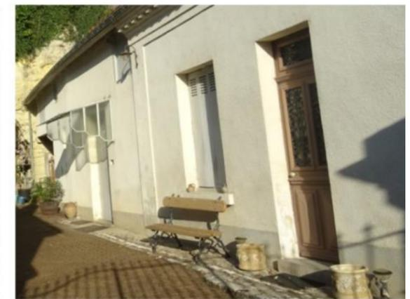
Porte en bois avec imposte vitré et partie supérieure avec vantaux et grilles de protection
