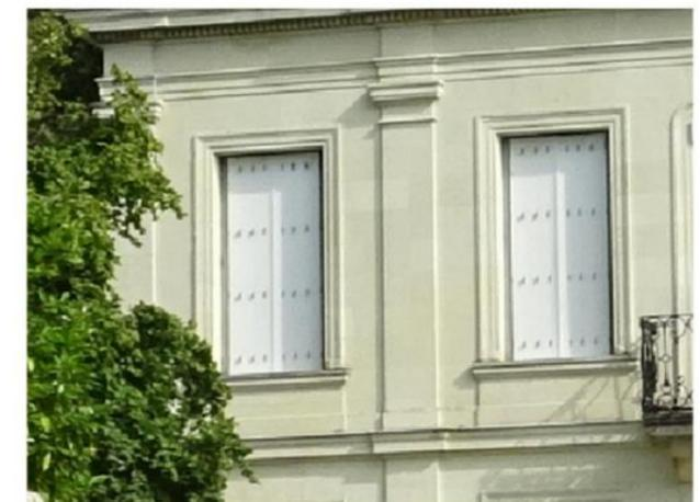
Maçonnerie en pierre de taille, modénatures qui soulignent la façade : encadrement en saillie, bandeau, pilastre encastré, corniche à modillons
