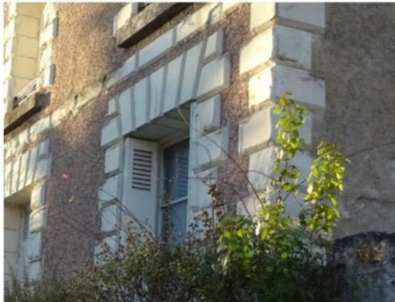
Maçonnerie en moellons enduit (reprise en ciment sur la façade principale), encadrements des baies et chaîne d'angle harpé en bossage.
