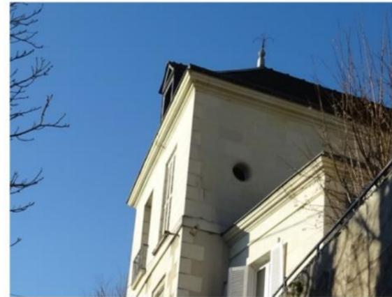
Mur-pignon surmonté d'une toiture à croupe. Il est couronné d'une corniche
