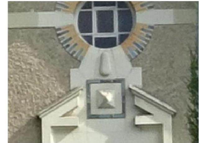
Décor singulier : linteau à fronton triangulaire interrompu et décor en modénature servant d'appuis à une baie de type oculus à encadrement en brique bicolore (brun-jaune et gris)
