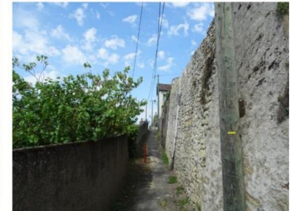
Système de double mur de soutènement d'un coté et de l'autre d'une venelle à mi-coteau
