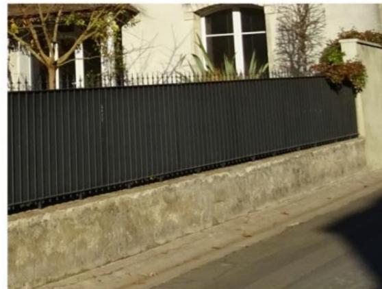
Mur bahut maçonné (moellons) et enduit surmonté d'une grille métallique sombre festonnée. Proportion de 1/3 de mur et 2/3 de grille.
