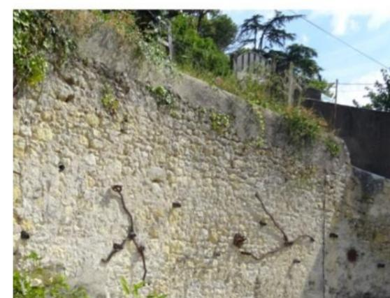
Mur de soutènement en moellons grossièrement équarris
