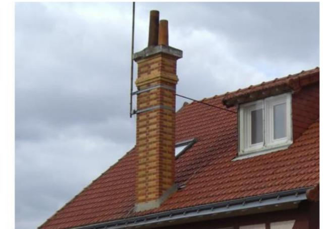
Cheminée en brique, deux couleurs, dessin ornamental dans l'appareillage des briques. Système de tirant assez discret
