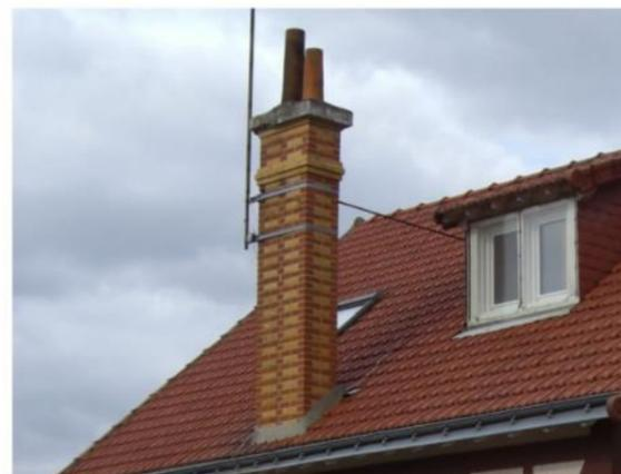
Cheminée en brique, deux couleurs, dessin ornemental dans l'appareillage des briques. Système de tirant assez discret
