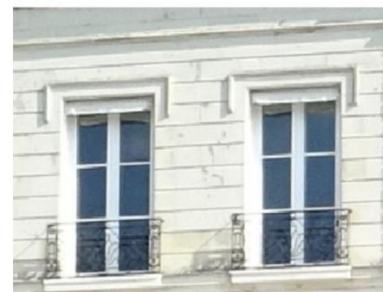
Maçonnerie en pierre de taille, joints creux
