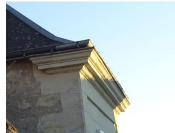
La corniche s'arrête à la chaîne d'angle qui fait la jonction avec la façade arrière de la construction : principe de hiérarchie des façades
