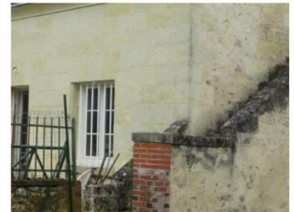
Maçonnerie de la façade principale en pierre de taille, avec linteau à plate bande, tandis que le mur-pignon est réalisé en moellons de calcaire
