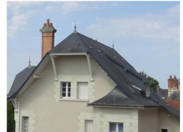
Toiture en demi-croupe en débord épi de faitage en zinc, éléments de charpente apparents
