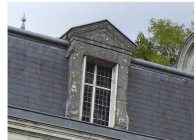
Lucarne classique en pierre de taille à fronton triangulaire, sur le brisis d'une toiture à mansarde
