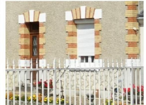
Mixité de matériaux en façade : soubassement en pierres calcaire appareillées façon "meulières", encadrements en béton peint, brique brun-jaune et brun-jaune
