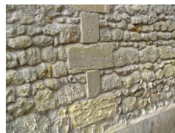
Chainage dans un mur de soutènement en moellons grossièrement assisés et équarris
