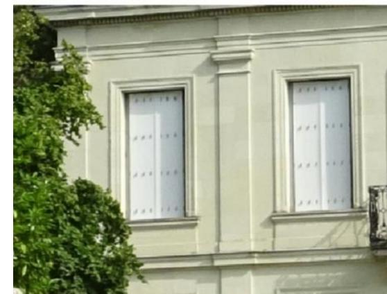
Maçonnerie en pierre de taille, modénatures qui soulignent la façade : encadrement en saillie, bandeau, pilastre encastré, corniche à modillons
