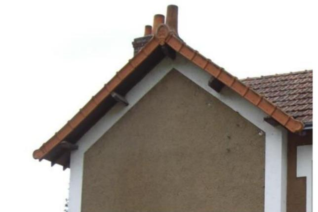
Exemples de couvertures en tuiles mécaniques avec l'emploi de tuiles de rabat et d'éléments décoratifs
