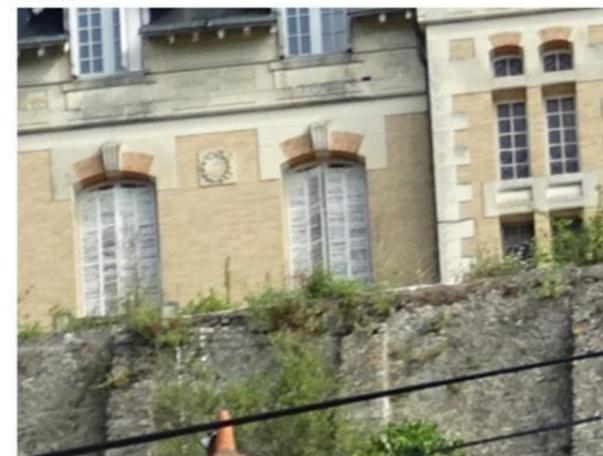
Façade du château de Sens, maçonnerie en béton et brique brun-jaune de parement. Pierre de taille en placage
