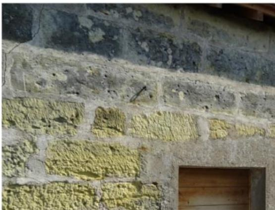
Maçonnerie en pierre de taille composé de Tuffeau jaune partiellement retaillé. Reprise du linteau en ciment malheureuse
