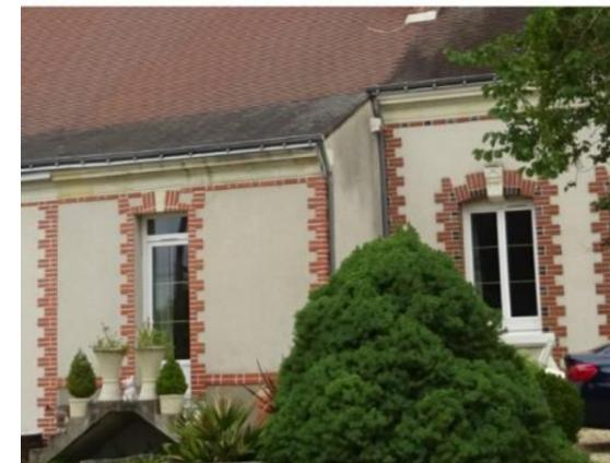
Maçonnerie ancienne enduite et encadrements et chaînes d'angles en brique de parement (la pierre doit encore exister dessous)
