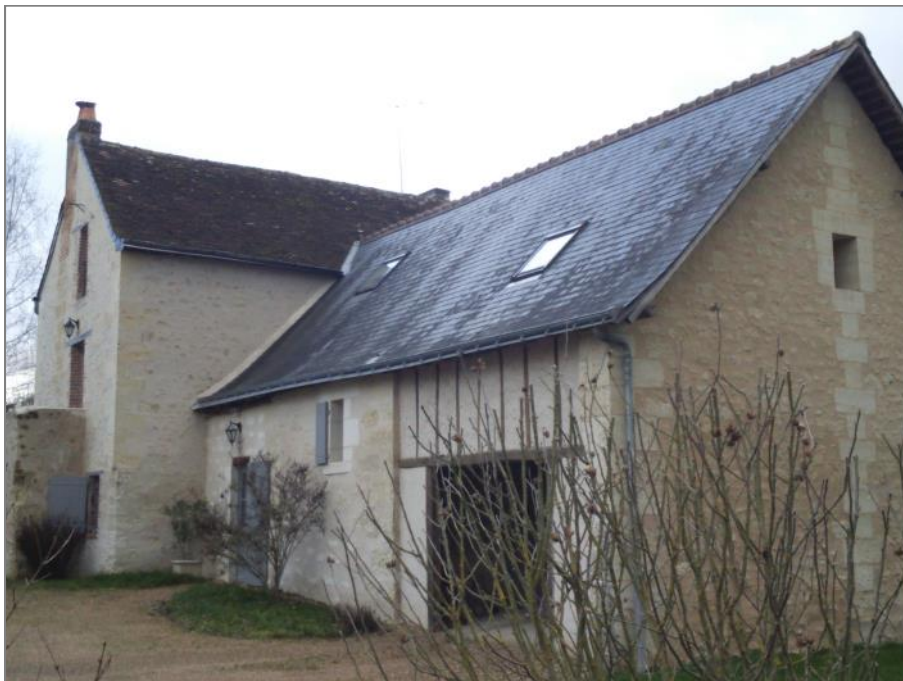
Restauration d'une ancienne ferme au Petit Vaudanière (en dehors ZPPAUP)
