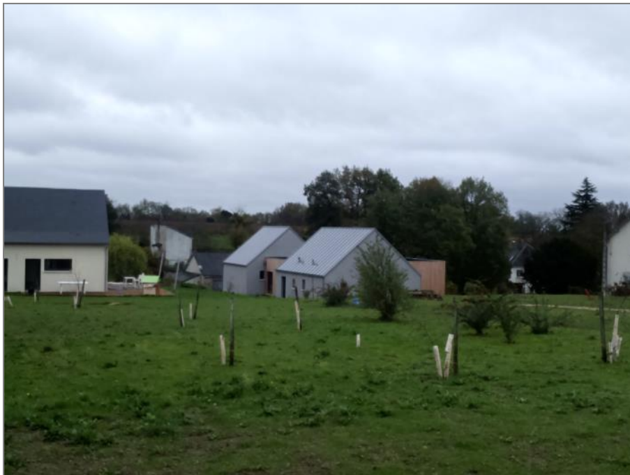
Maison individuelle contemporaine (couverture zinc) rue Saint-Georges
