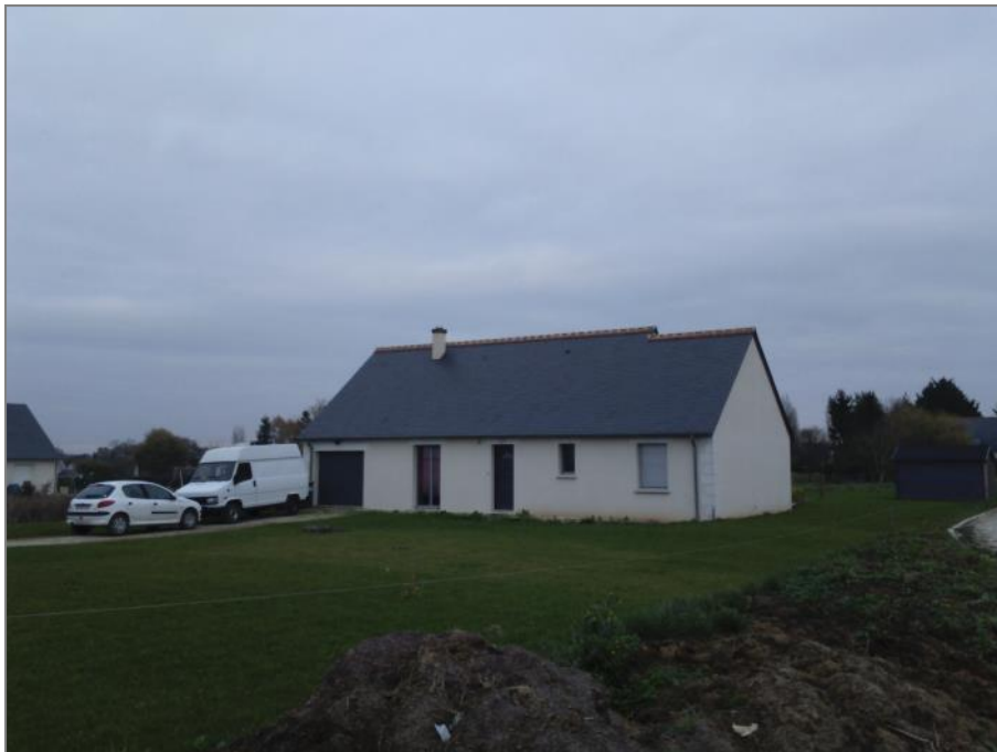
Constructions nouvelle (à proximité du chemin de Mosny)
