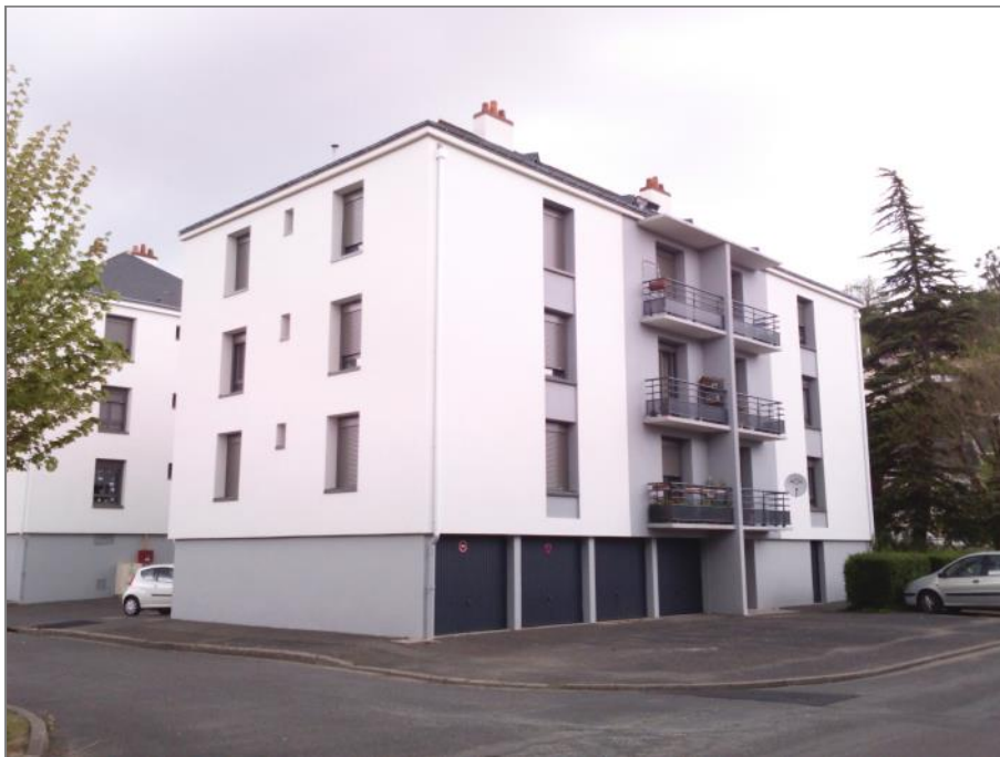
Réhabilitation récente des logements sociaux de la rue du Moulin
