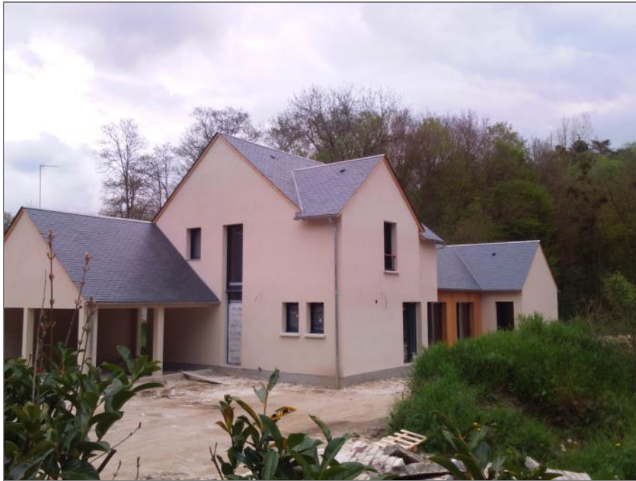
Constructions nouvelle rue des Fontenelles, mélange architectural entre le volume traditionnel et l'ajout contemporain (matériaux bois)
