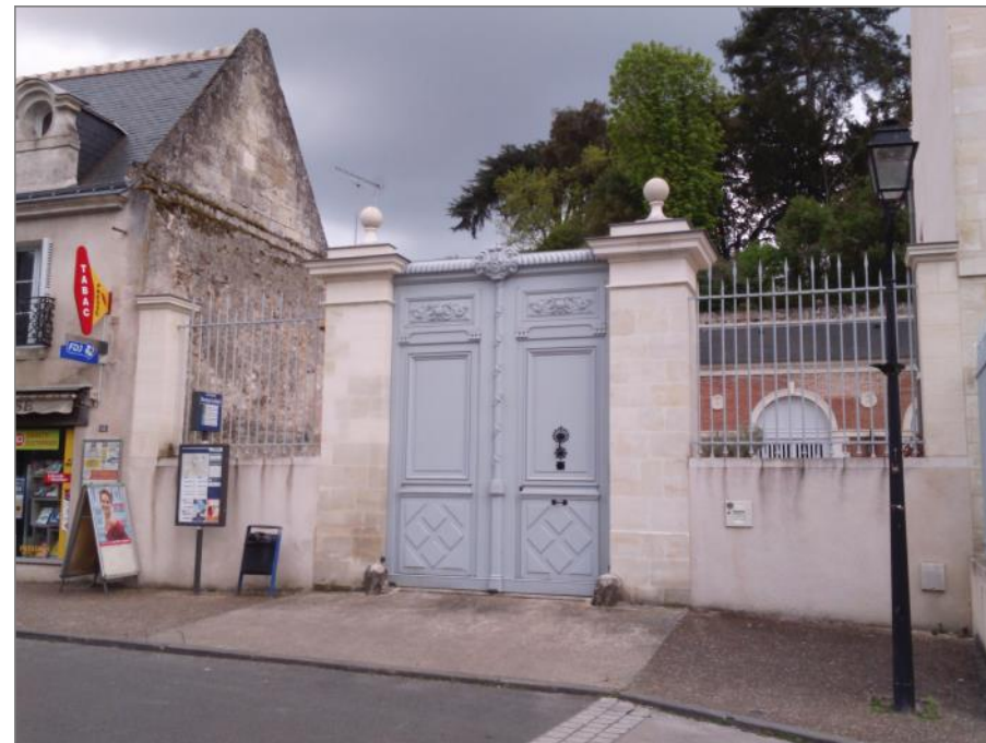
Restauration d'un portail traditionnel en bois
