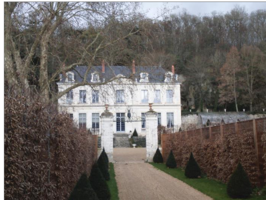
Façade restaurée d'un château sur les bords de Loire
