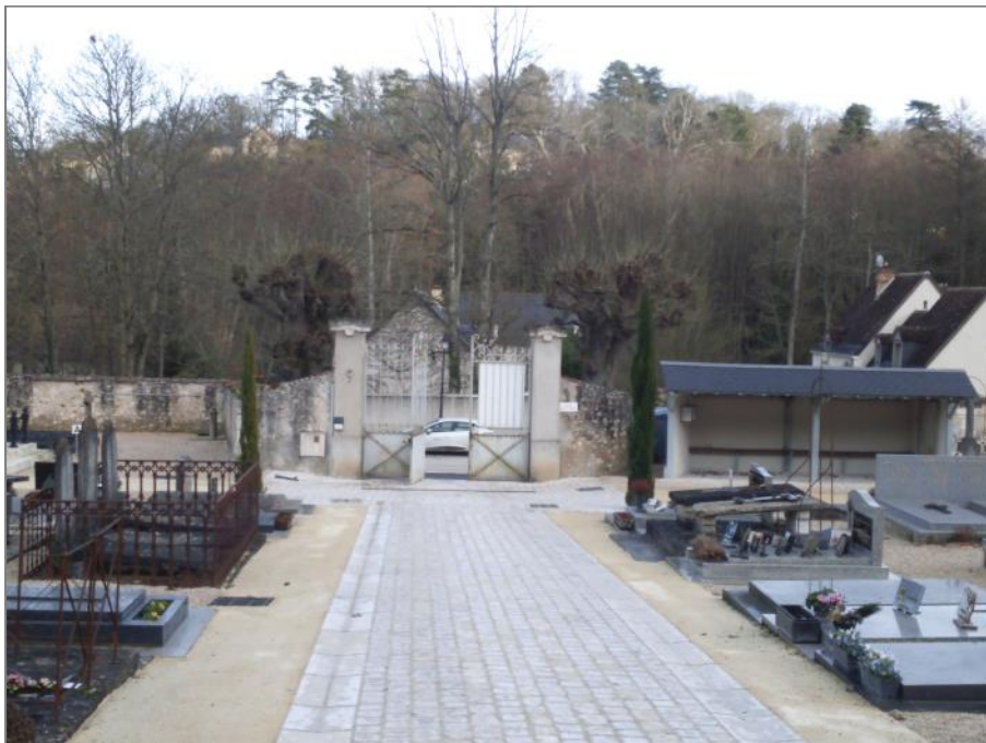
Réaménagement du cimetière avec des pavés calcaires et du stabilisé calcaire
