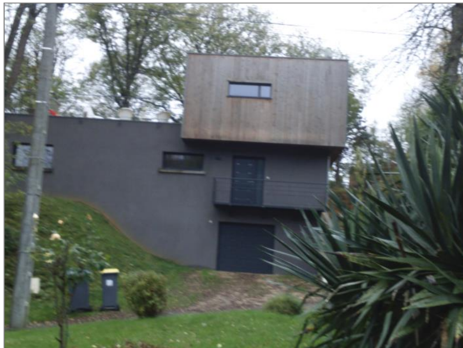
Construction contemporaine à Bel-Air (en dehors ZPPAUP)
