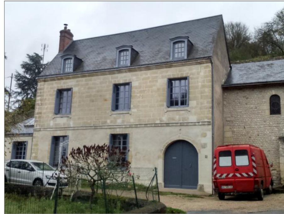
Restauration d'un bâtiment qui jouxte la chapelle Saint-Georges
