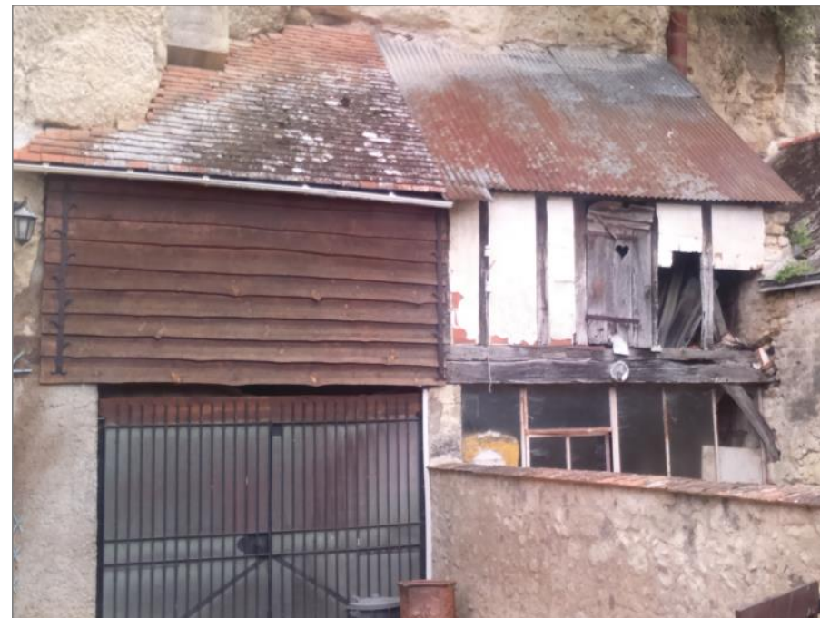
Imbrication de bâti vernaculaire en pied de coteau
