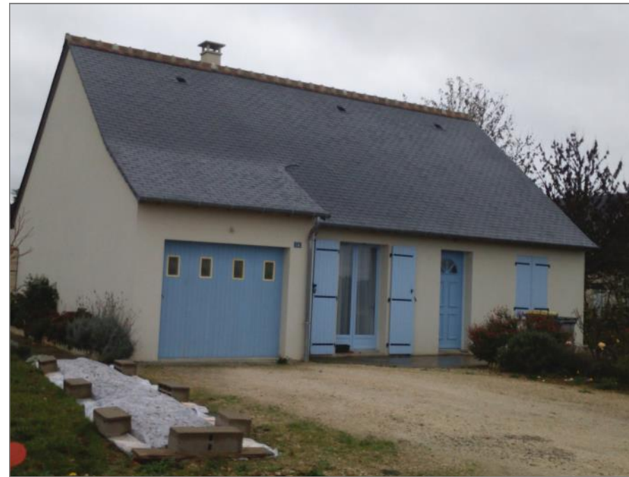
Menuiseries bois peintes dans un bleu pastel : la couleur ne correspond pas au style de la construction (maison « rurale »)
