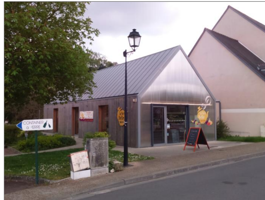
Espace de restauration en face de l'Eglise (couverture zinc, façade en polycarbonate)
