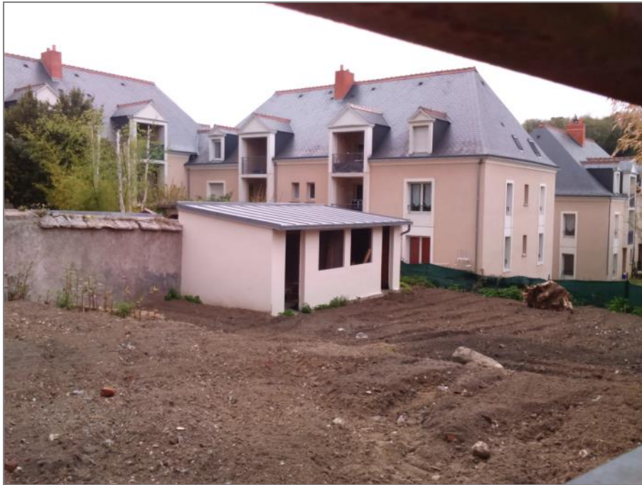
Annexe au logement à l'arrière d'un bâtiment rue du Docteur Lebled
