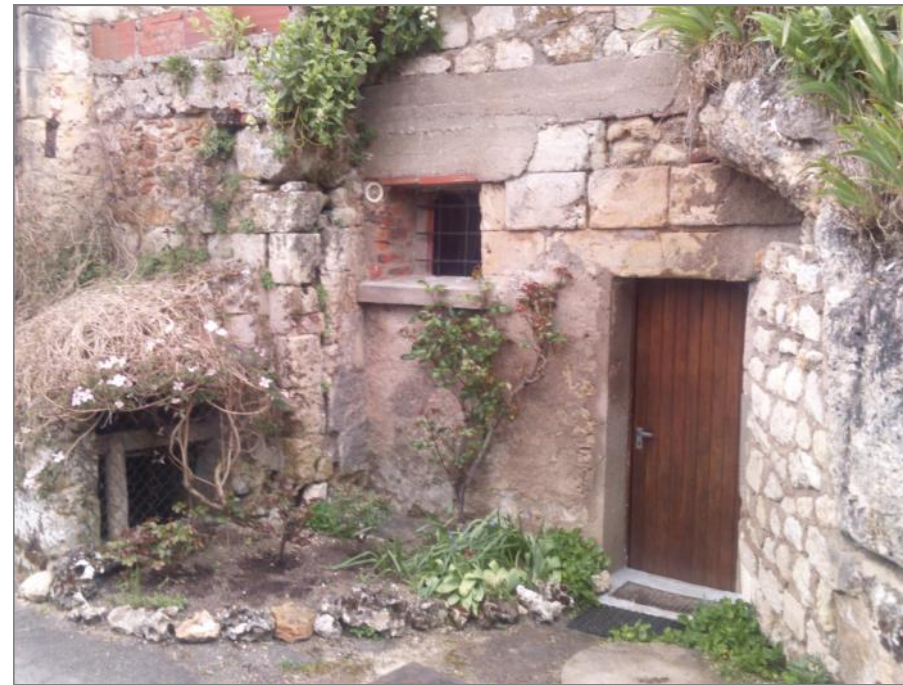
Rue Elisabeth Génin : entrée d'habitat troglodytique avec puits
