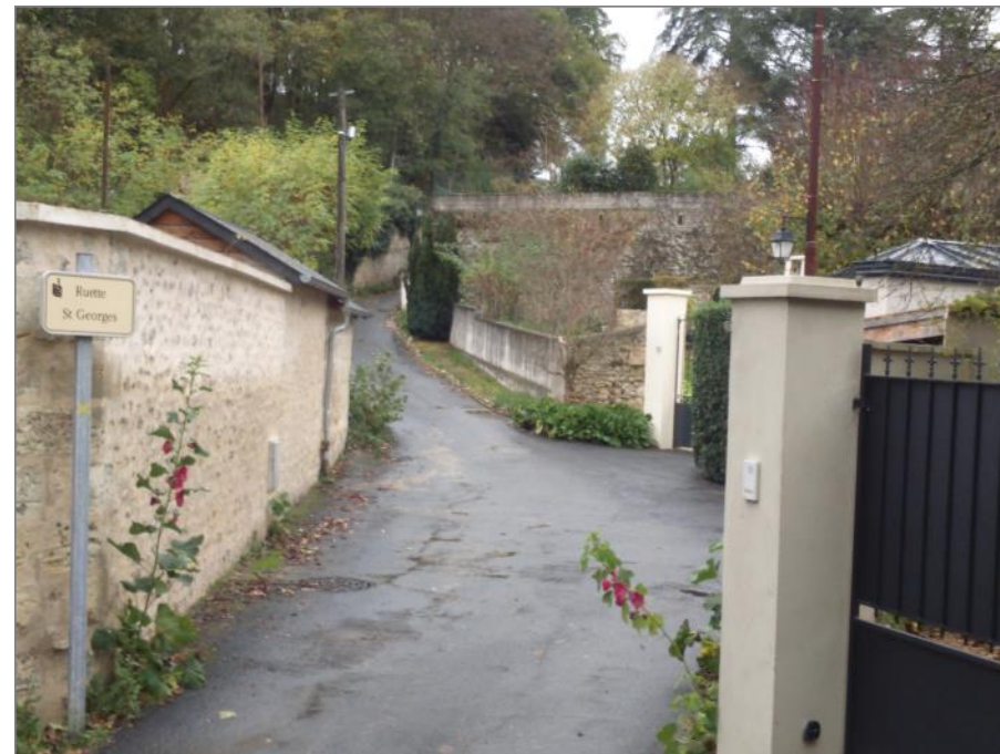
Restauration d'un mur avec pierres apparentes et paysage bâti de murs de clôtures et de soutènement (Saint-Georges)
