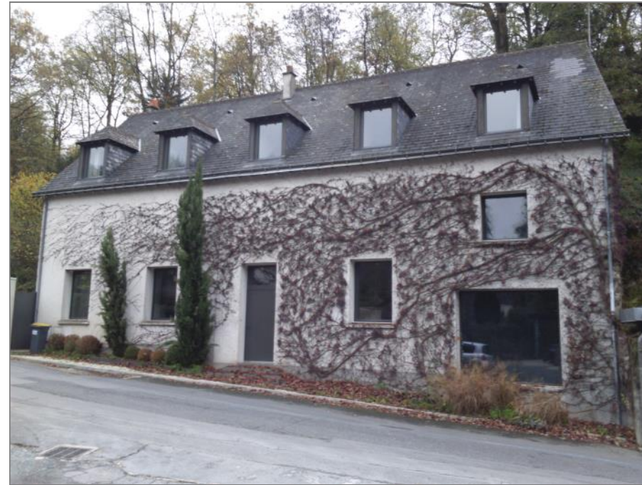
Réhabilitation d'un ancien chai à Saint-Georges, les pleins jours des menuiseries et la multiplication des lucarnes confère un caractère atemporel déroutant dans le contexte très patrimonial
