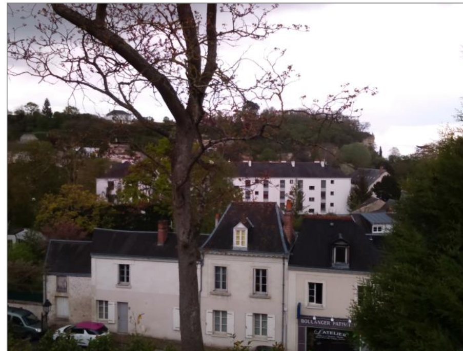
Vue de la réhabilitation des logements sociaux depuis le sentier de la Butte
