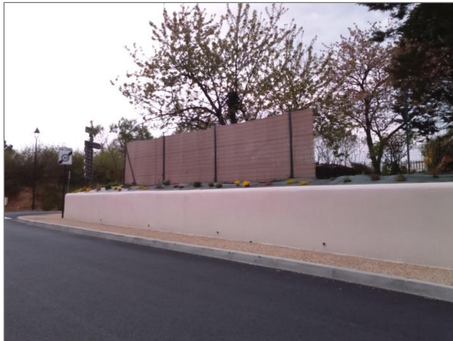
Mur contemporain enduit (surmonté d'un simple grillage)
