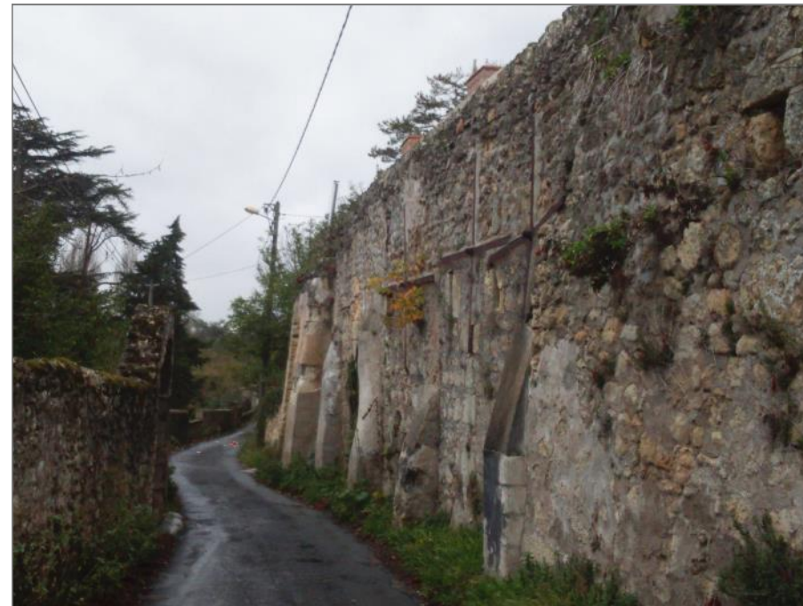
Problématique de l'entretien des murs, surtout s'ils font office de soutènement (rue de Beauregard)
