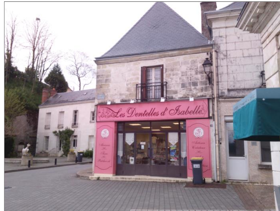
Devanture commerciale ayant un impact négatif sur l'environnement patrimonial (au-delà de la couleur, c'est plutôt la forme de la devanture qui rompt avec l'architecture)
