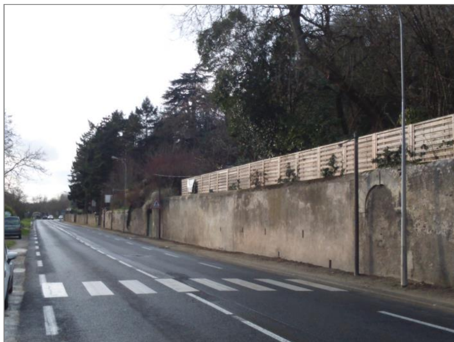
Mur de clôture traditionnel surmonté d'une palissade bois
