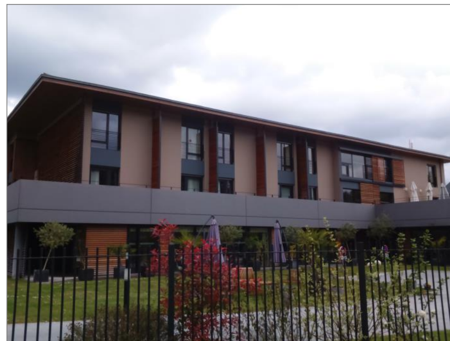
Nouvel EHPAD de Rochecorbon, à proximité du centre ancien
