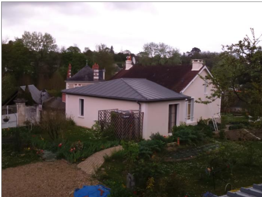
Extension récente avec toiture zinc rue du Docteur Lebled
