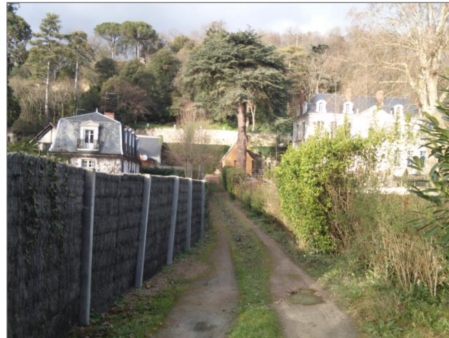
Venelle accessible depuis les quais de Loire avec brandes et poteaux béton et haie de type bocagère
