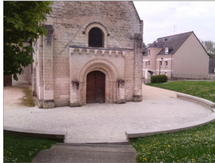
Aménagement du parvis de l'église
