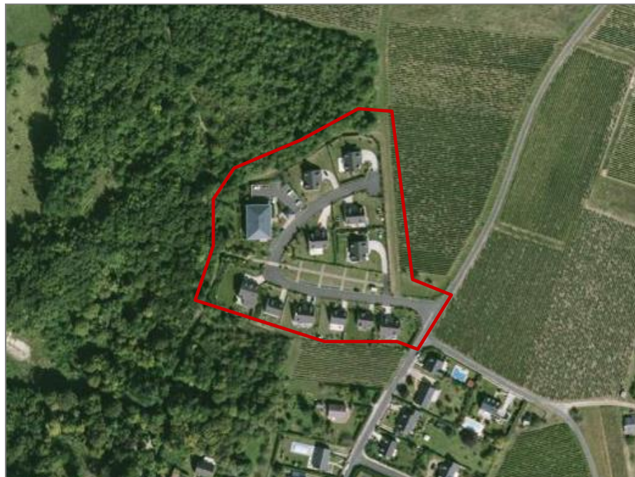
Photographie aérienne d'un lotissement neuf rue des Bourdaisières
