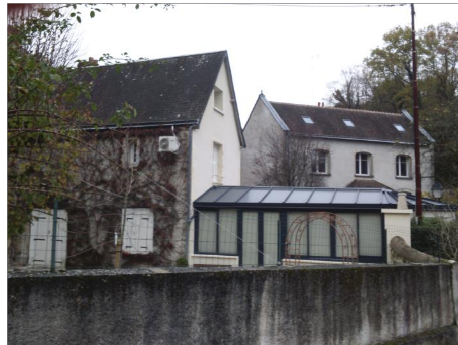
Extension récente de type véranda à Saint-Georges
