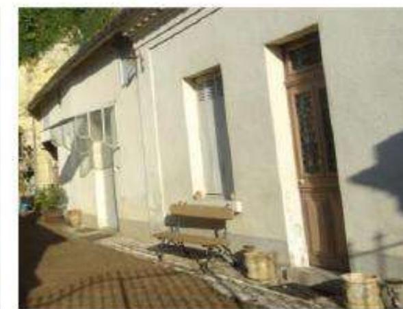
Porte en bois avec imposte vitré et partie supérieure avec vantaux et grilles de protection.
