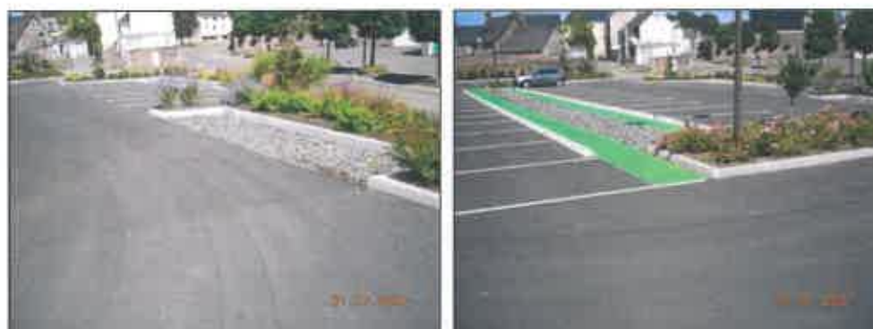
Photo 4 : Exemple de tranchées drainantes
