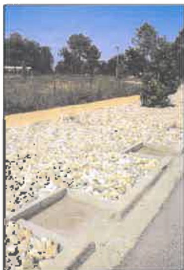
➤ Tranchées le long de la voie
