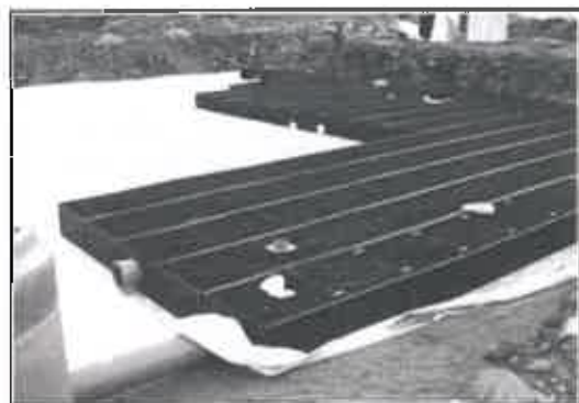
► Système D-Raintank® Chantier à Vannes
