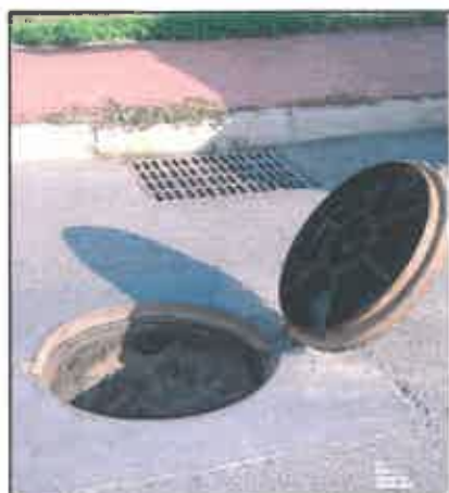
➤ Puits d'infiltration sur voirie (à éviter)
