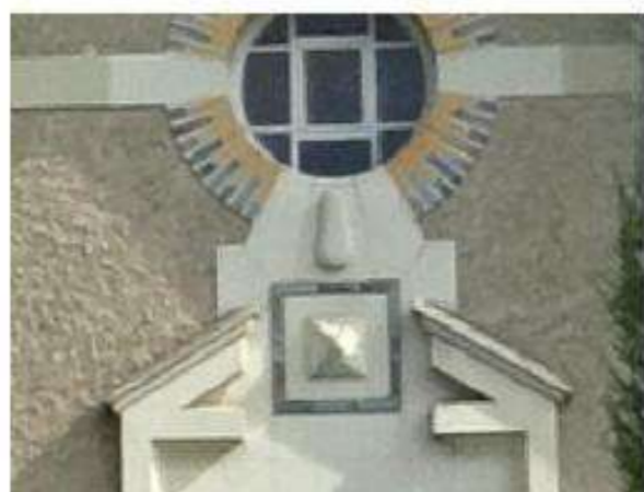
Décor singulier : linteau à fronton triangulaire interrompu et décor en modénature servant d'appuis à une baie de type oculus à encadrement en brique bicolore (brun-jaune et gris).
