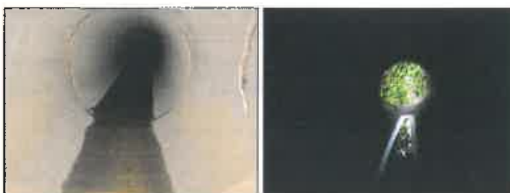
Photo 5 et 6 : vue amont et aval du regard 0329 rue de l'Eglise (Bassin versant 16)
