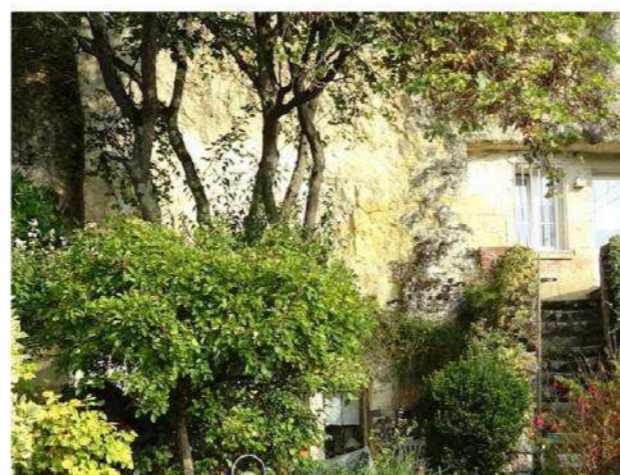
Escalier d'accès au logement troglodytique
