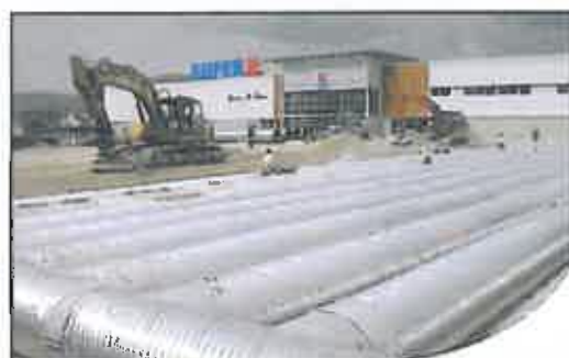
► Rétention EP visitable sous voirie SPIREL®- TURBISIDER
