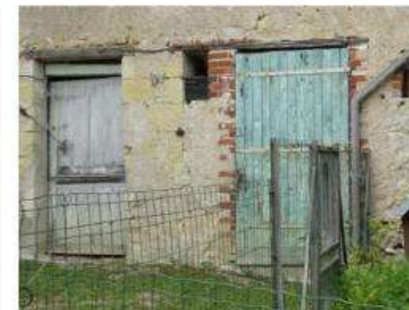
Ancienne menuiseries, et notamment une porte fermière en bois peint à restaurer.
