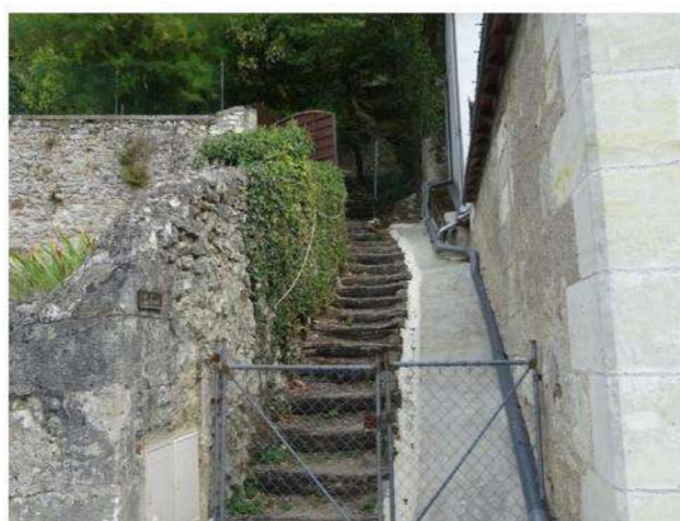
Escalier privé doublé d'un caniveau d'évacuation des eaux de ruissellement du plateau
