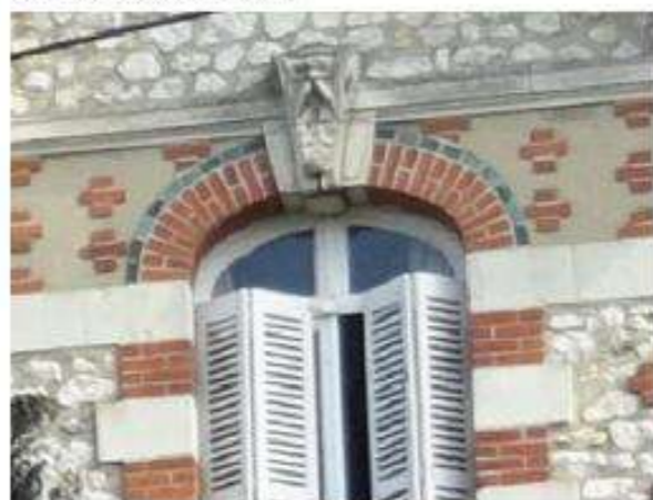
Clé de linteau sculptée en saillie. Linteau en anse de panier constitué d'é briques rouge (en panneresse et boullisse) surmonté d'un rang de briques Amalbec rose. N.110.
