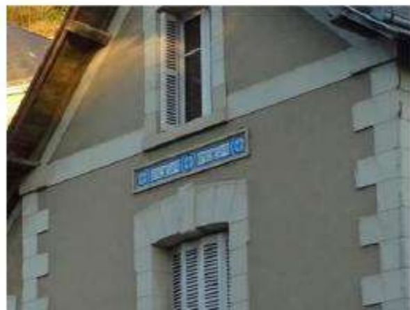
Plaque d'un motif décoration en carreaux de ciment peint, à la manière d'un médaillon de forme rectangulaire.
