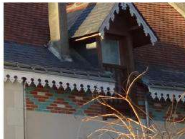
Frise en brique tricolore (bleu, rouge, blanc) sous égout habillé d'un lambrequin en bois peint blanc.
