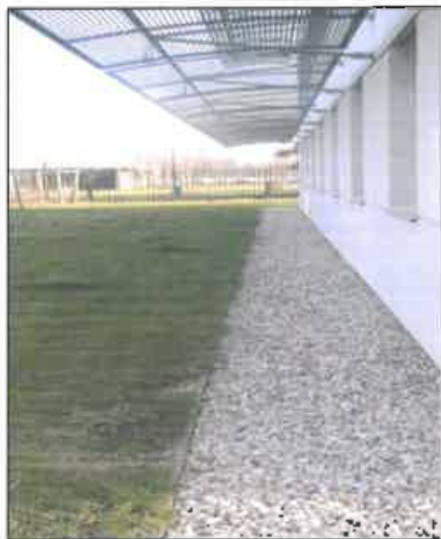
➤ Tranchées sous toit
