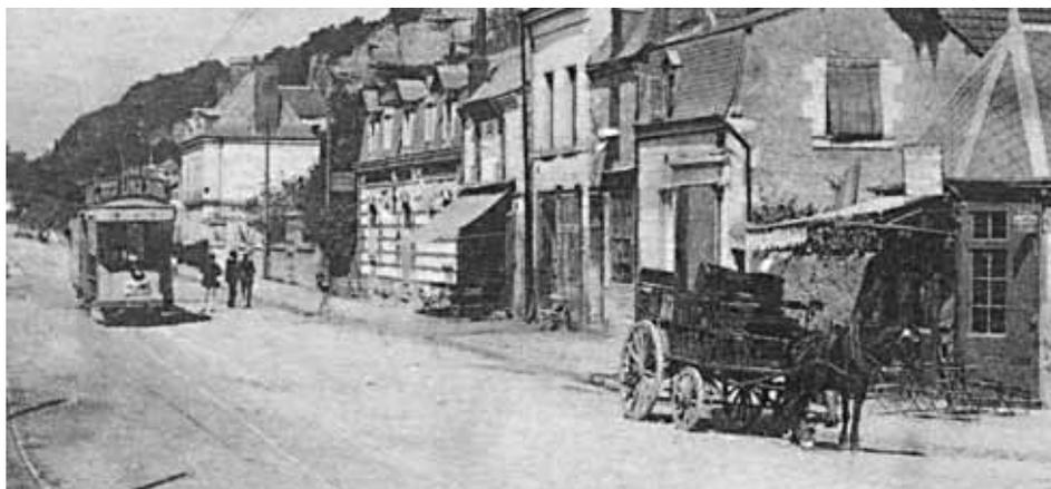
Tramway électrique sur le quai de Rochecorbon. La voie est double pour permettre le garage et le croisement des trains.
