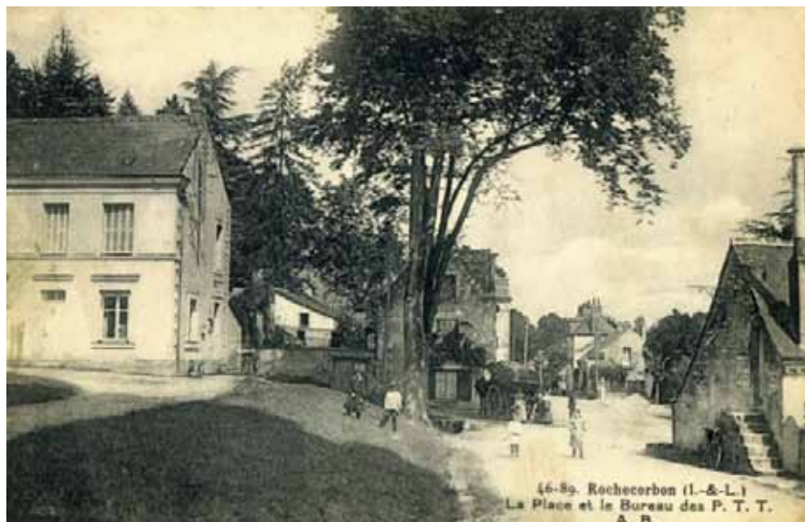
Le bâtiment de la poste tel qu'il était à sa construction : la porte d'entrée du public se situait alors à droite, sur le pignon.
