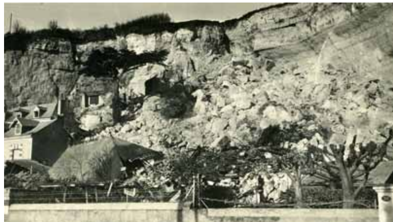
Le toit intact "chapote" les ruines de la maison
