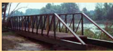
La passerelle sur place avant son installation
