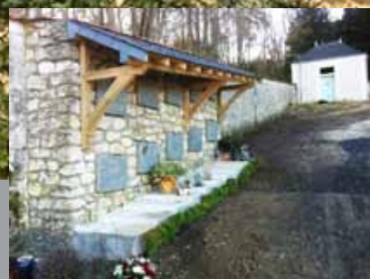
Aménagement du cimetière
