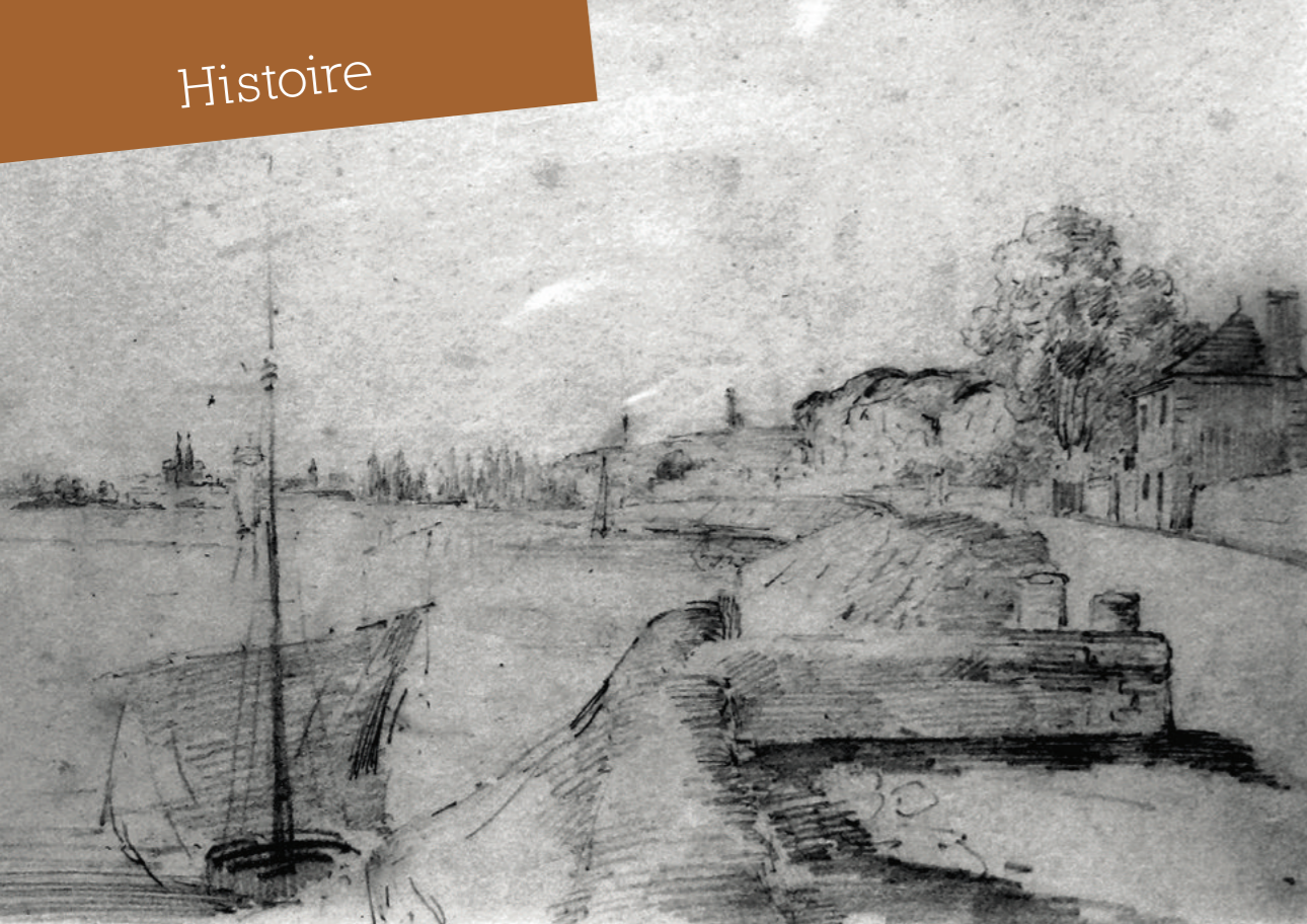
Port de Vauvert vers 1900
