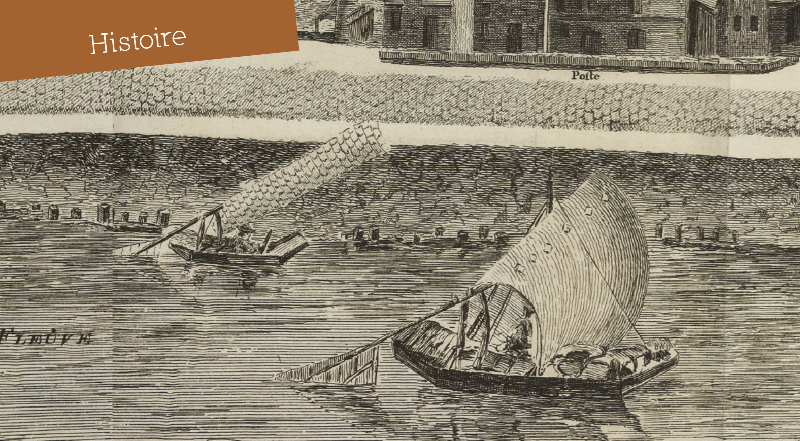
Exemple de cale à Saint-Mars-la-Pile en 1770. Cette cale était pavée.
