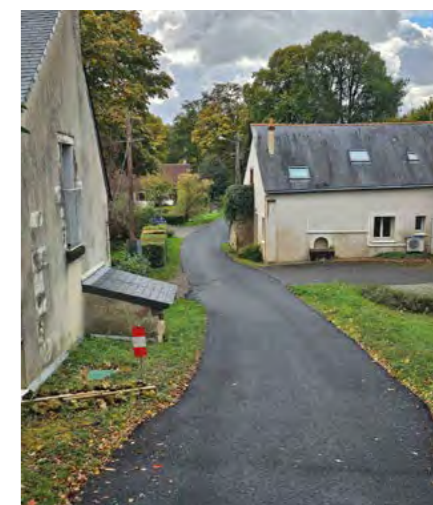
Réfection de l'enrobé de La Vallée Poëlon
