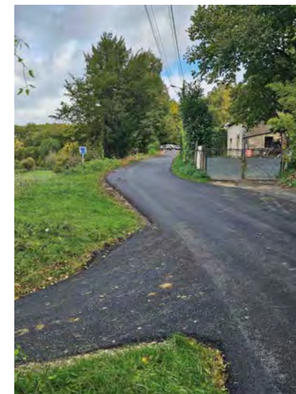
Réfection et gravillonnage bicouche de La Millardière
