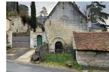
La chapelle Saint-Germain, bas de la rue Saint-Georges. C'est dans l'ancien cimetière (recouvert fin XVIII e par un atelier de tonnellerie couvert de tuiles) que furent inhumées en 1662 neuf personnes de rite protestant. Photographie de l'auteur.
