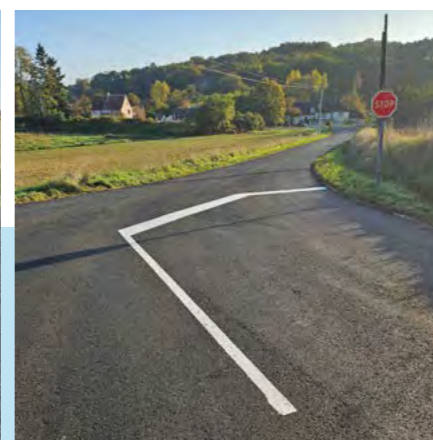
Réfection et gravillonnage bicouche de la route de la Valinière
