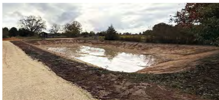
Création du bassin de rétention rue Saint-Georges
