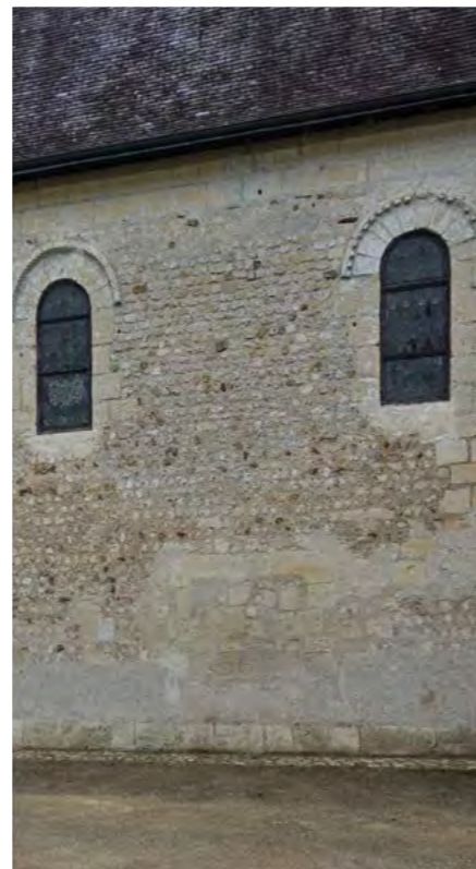
Les deux « portes des morts » des églises de Rochecorbon : tout en haut à Saint-Georges la petite porte a été agrandie juste avant 1689 pour servir d'entrée principale, ci-dessus celle de Rochecorbon qui au contraire devenue inutile fut bouchée. Photographies de l'auteur.
