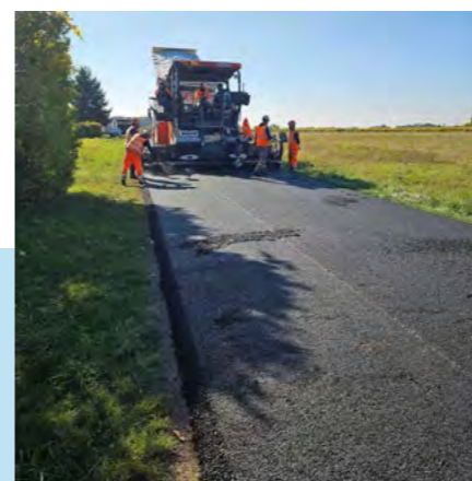
Réfection et gravillonnage bicouche de la route de la Valinière
