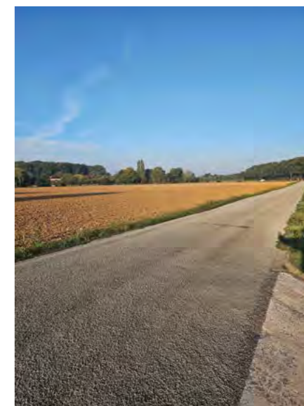
Réfection et gravillonnage bicouche du chemin de Mosny
